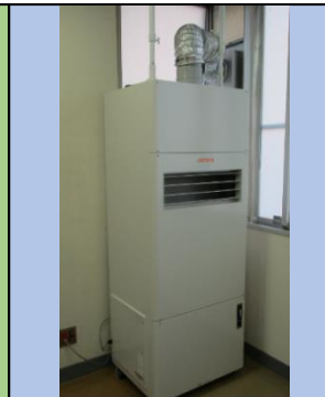
発熱者専用の診察室に新たに「陰圧装置」を設置しました。
