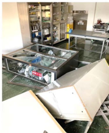
手術材料保管庫などが倒れた様子
