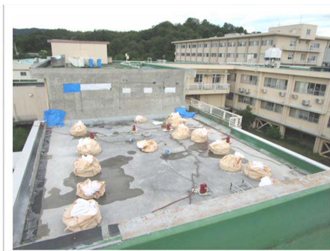
解体された大会議室の様子
