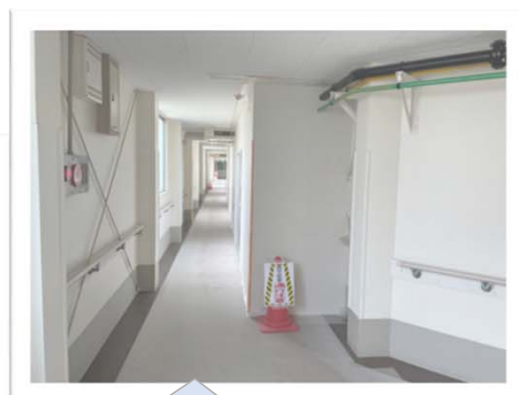
南病棟への渡り廊下の様子
