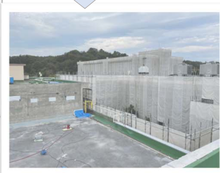
中央病棟などの 外壁補修の様子
