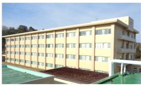
中央病棟（修繕後）
