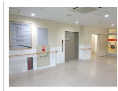
エレベーターホール（修繕後）
