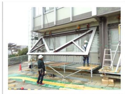
外来棟耐震補強工事の様子
