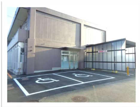
外来北側（整備後）
