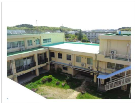
外来管理治療棟 大会議室解体後
